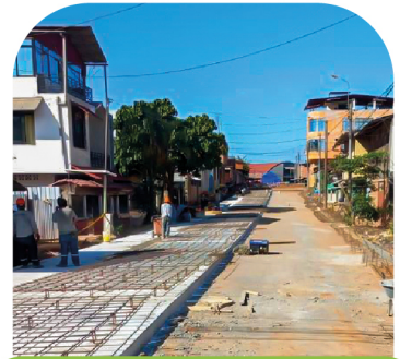
MEJORAMIENTO DE LAS PRINCIPALES CALLES DEL BARRIO EL TREBOL
